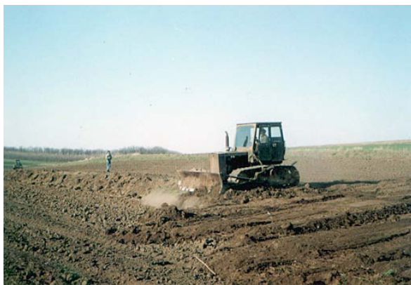
Foto 13 Lucrări de modelare – nivelare pe terenurile arabile în pantă, erodate
