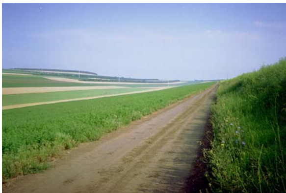
Foto 14 Drum de exploatare agricolă orientat după direcția curbelor de nivel
