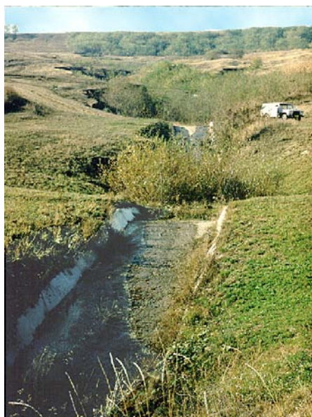
Foto 26 Baraj de pământ pe fund de ravenă
