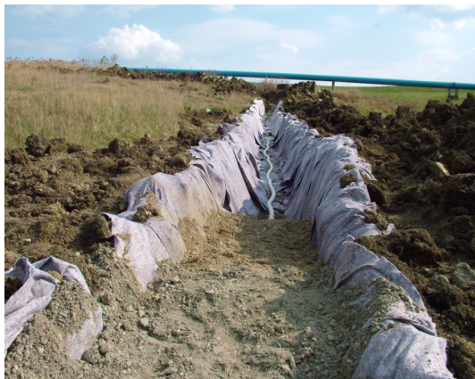
Dispozitive experimentale pentru evaluarea eficienței ameliorative a rețelilor de drenaj (Leorda)
