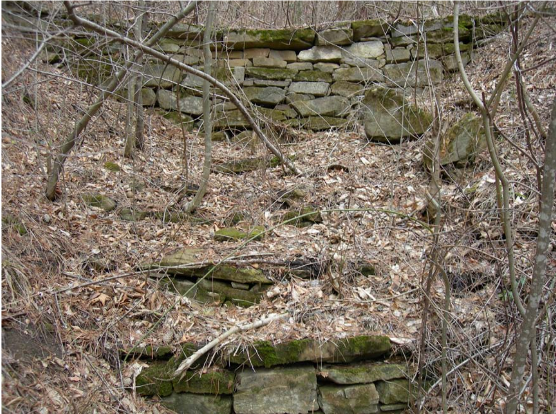
Praguri din zidărie uscată în perimetrul Scaune, Valea Sării, jud. Vrancea
