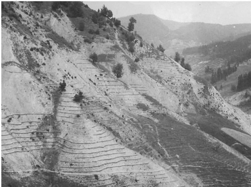
Terenuri ravenate în perimetrul Bârsești, jud. Vrancea, în anul 1977, în timpul execuției lucrărilor de amenajare
